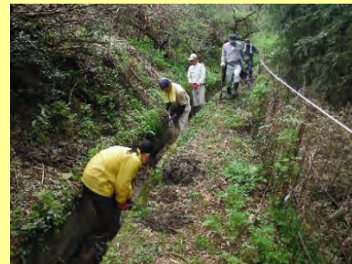
水路清掃（泥上げ）
