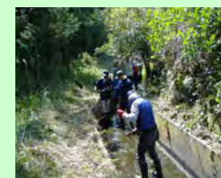
水路泥上げ作業
