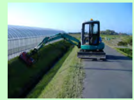
水路法面草刈り
