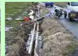
土水路から コンクリート水路へ整備
