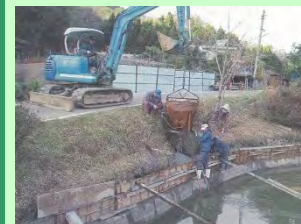
コンクリート擁壁の嵩上げ
