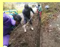
水路の泥上げ
