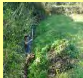
水路の泥上げ
