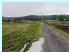
水路が未整備
