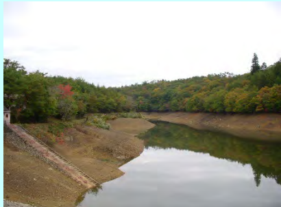
地区内のため池の一つである「小原池」
