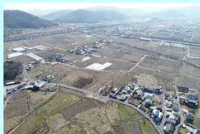
ほ場整備事業実施前の 齋富地区の状況
