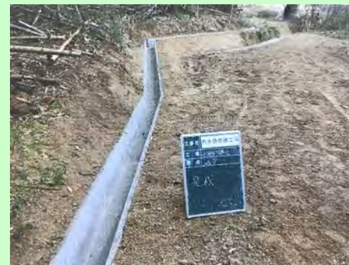
水路本体の更新 約150m （R4年度実績）
