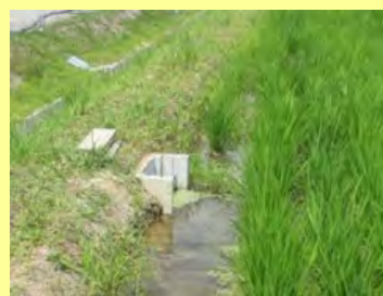
調整堰板の 設置状況
