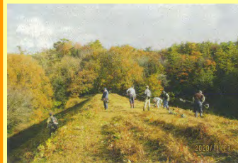
ため池堤体の草刈り
