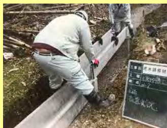
水路の据付作業
