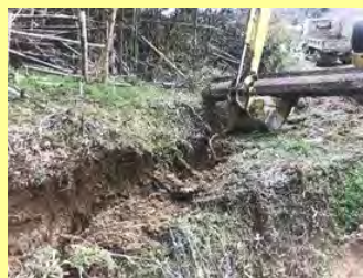
既設水路撤去作業
