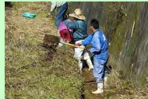
水路の泥上げ
