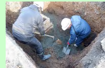
空気弁更新作業
