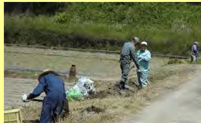
復旧作業の様子
