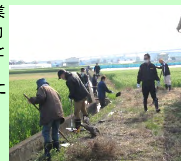
水路の泥上げ
