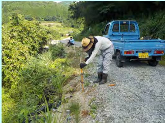
電気柵の設置
