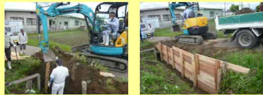
木柵の直営施工
