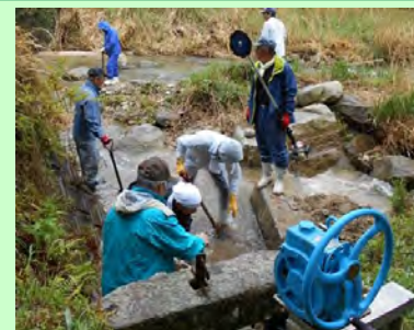
水路の泥上げ
