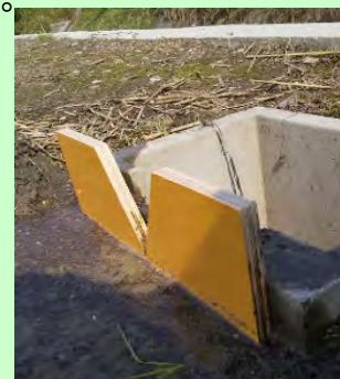
堰板の設置状況
