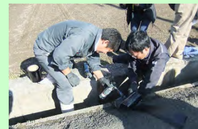
水路目地補修講習会
