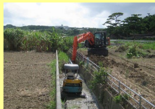
直営施工による水路の泥上げ状況
