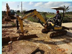
重機による側溝の泥上げ
