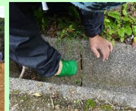
細かな補修作業
