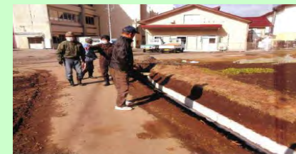
長寿命化工事(直営)を終えて竣工検査(R4)
