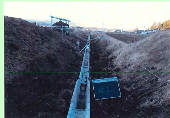
施工後の状況
