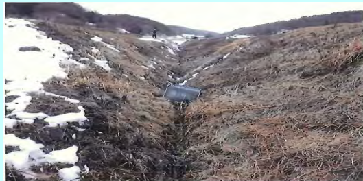
土水路の状況
