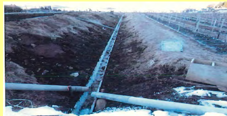
水路の設置状況
