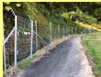
対策フェンス
