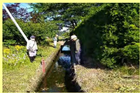
水路危険箇所点検(側壁が老朽化)
