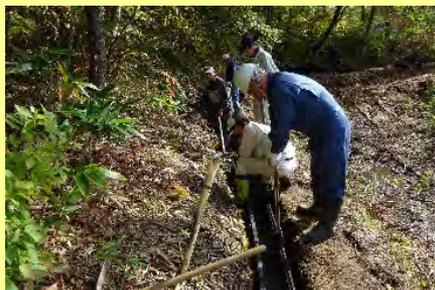
直営施工によるコンクリート水路施工
