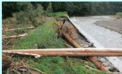
川の氾濫により管理用道路に流木が散乱 (重機がなければ対応困難)
