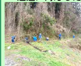
水路の維持管理
