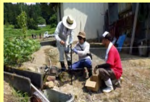
青年部の参加による 電気柵の設置
