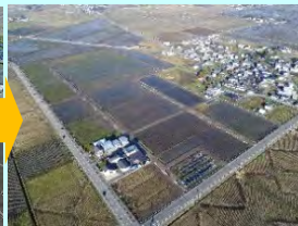
ほ場整備施工後
