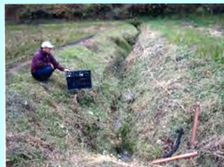
老朽化水路の確認
