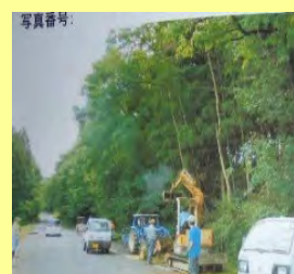
支障木の撤去
