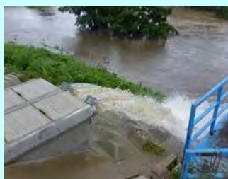
ポンプによる排水の様子
