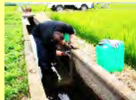
水路の目地詰め
