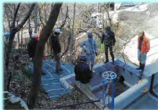
構成員による水路の点検
