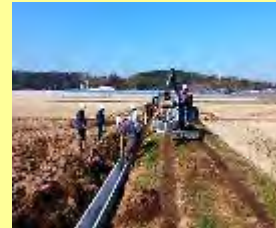
直営施工による 水路の更新工事
