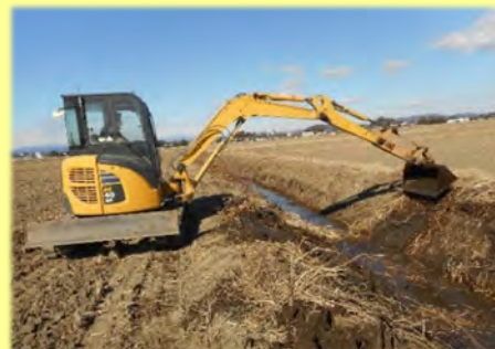
直営施工による水路の更新
