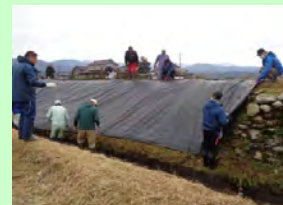
直営施工による 防草シートの設置
