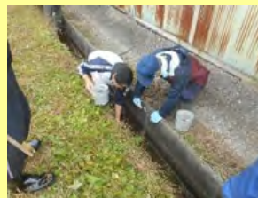
直営施工による水路の目地補修
