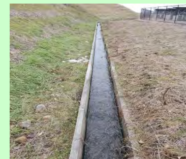
直営施工後の水路
