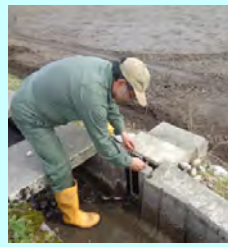
簡易水門の点検
