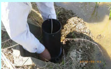
調整管の設置状況
