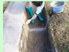
目地補修の直営施工
