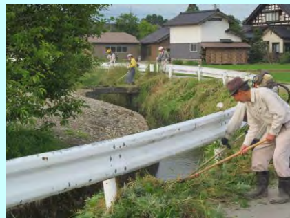
施設の維持管理作業
