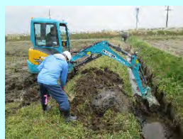
水路の初期補修
