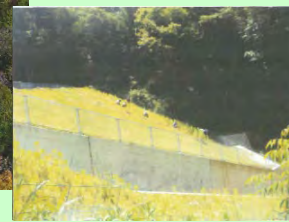
ため池の維持管理状況
