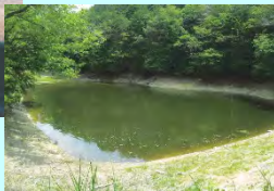
改修前の大洞ため池
