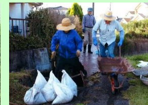
水路の泥上げ
