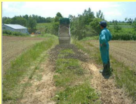
農道の補修・更新
