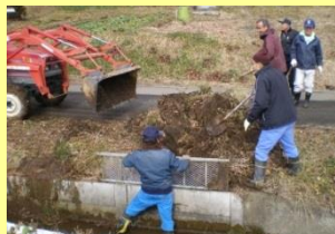
（水路側壁の補修）
