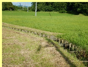
景観に配慮した木柵水路
