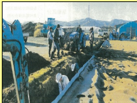
水路の泥上げ
