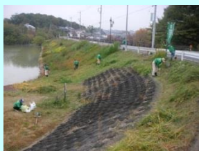
濁池の草刈作業
