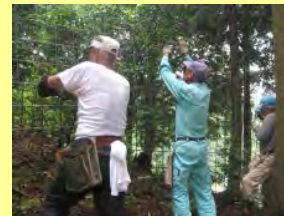
獣害柵の補修管理
