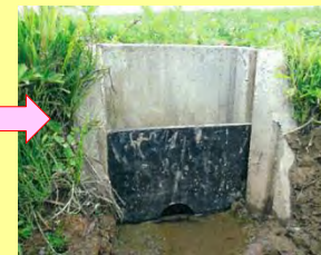
水戸板設置状況
