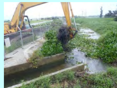
湛水未然防止のため土砂さらい
