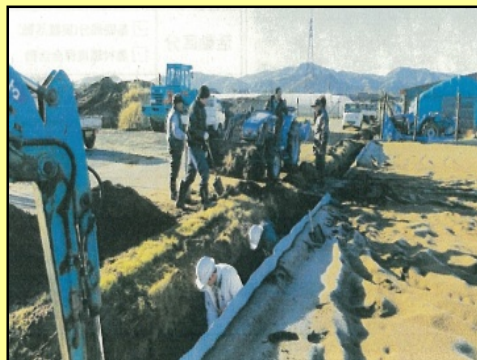
水路の泥上げ
