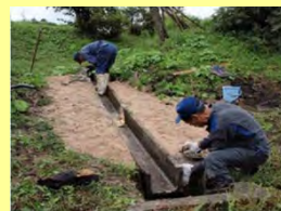
直営施工（水路の補修）
