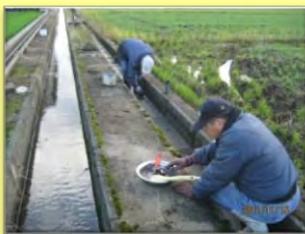
自主施工による目地補修
