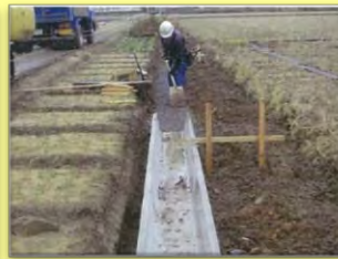
二次製品水路敷設
