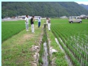
改修してから20年程度だが、地盤が悪いため、水路底と側壁の隙間が生じ漏水が発生している。
