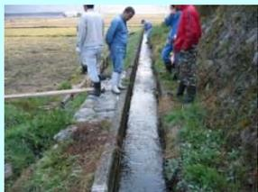
狭く未舗装の農道と老朽化によって壊れている石積水路
