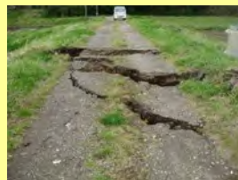
水路及び農道の破損状況
