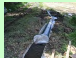
仮設配管の敷設状況
