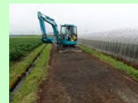
農道の復旧状況
