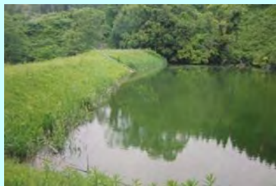
地域の貴重な水源であるため池
