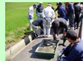
目地詰め作業
