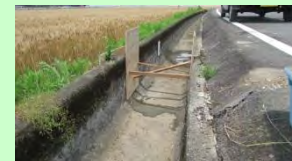
大きな破損箇所も、ベニヤ板の型枠を使って補修
