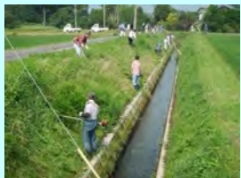
水路法面の草刈り
