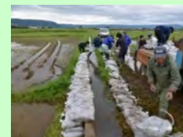
土のうの積み上げ作業
