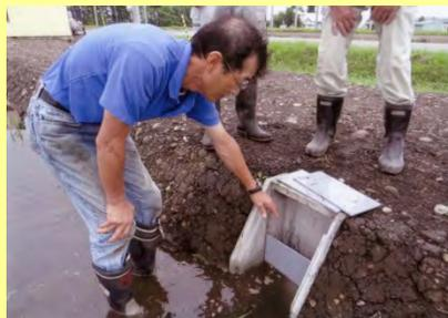
落水工に板を設置して、大雨時の排水量を減らすことにより、田んぼに雨水を一時的に貯留し洪水被害の軽減を図る。
