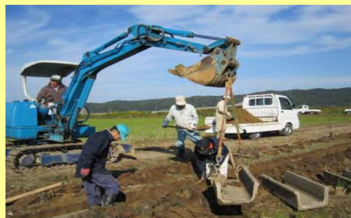
自主施工による水路の布設替え
