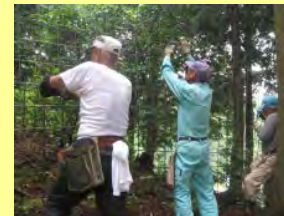
獣害柵の補修管理
