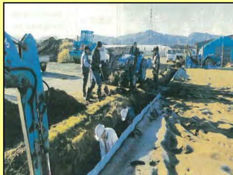
水路の泥上げ
