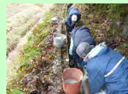
開水路の水漏箇所を目地詰め
