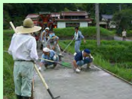
農道のコンクリート舗装
