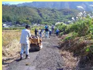
廃アスファルトで農道舗装。
