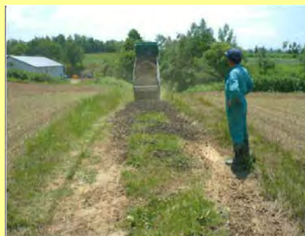
農道の補修・更新
