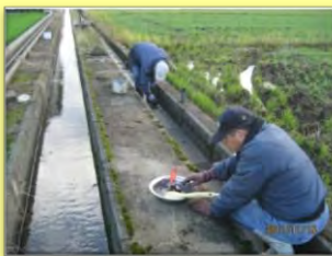
自主施工による目地補修
