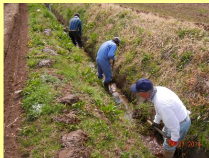
水路の泥上げ
