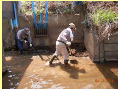
取水ゲート前の泥上げ
