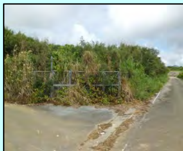
作業前の浸透池
