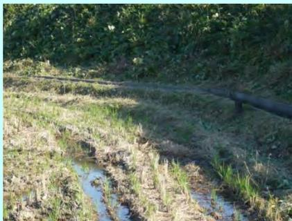
老朽化水路からの漏水状況
