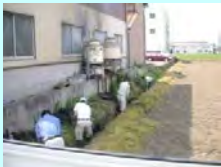
水路の泥上げ
