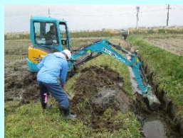
水路の初期補修
