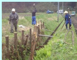
水路の補修作業
