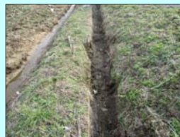
破損した用水路
