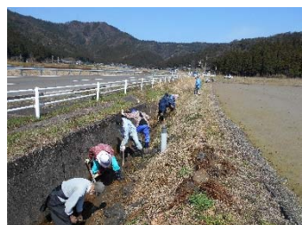
水路の泥上げ
