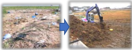
大雨により農地に堆積した流木等を地域共同で撤去
