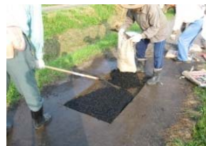
農道の補修 (対象組織が実施)
