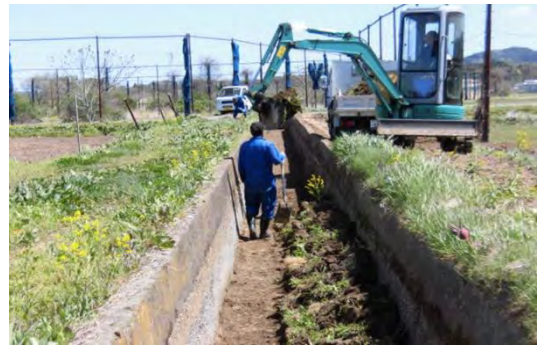
水路の泥上げ作業の様子
