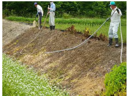
芝の吹き付け作業
