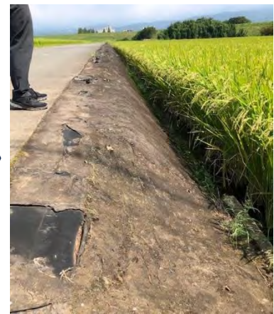
防草シート設置
