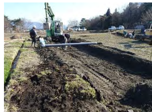
建設中のホタル水路
