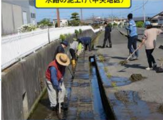
水路の泥上げ(中央地区)
