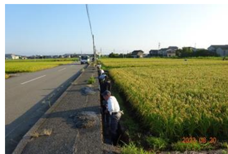
泥上げの様子
