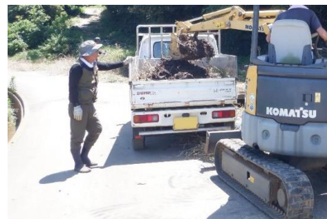
水路の泥上げ
