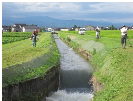
幹線水路溝畔の一斉草刈り
