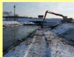
沈砂池の泥上げ （3年に1回（沈砂池数7））
