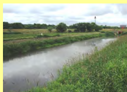
草地からの土砂を沈殿させて、 写真奥側下流の釧路湿原へ排水
