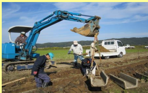
自主施工による水路の布設替え
