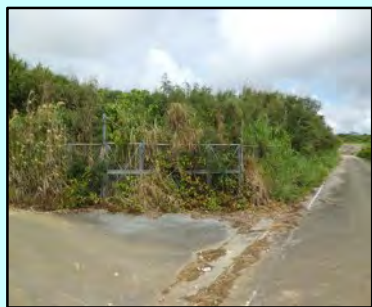
作業前の浸透池
