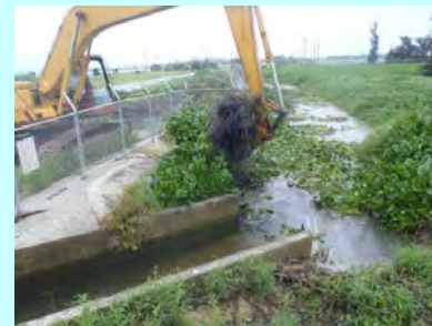
湛水未然防止のため土砂さらい
