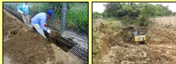
側溝や浸透池の泥上げ
