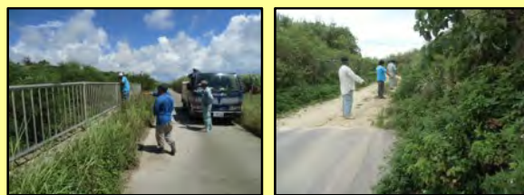
組織による施設の点検
