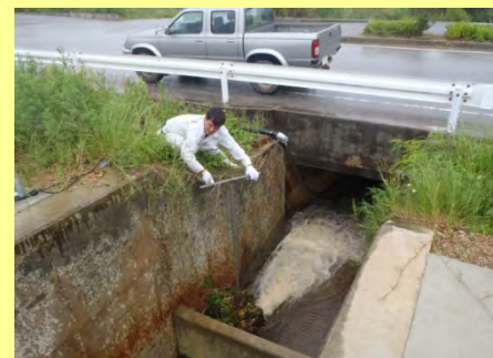
豪雨前にため池の水を抜き、水位調整のためゲート操作を実施
