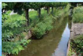
▲きれいに整備されている雑田堀用水
