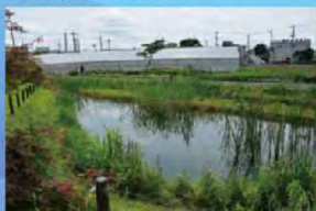
▲完成した「雑田堀親水公園（じょうとほり）」
