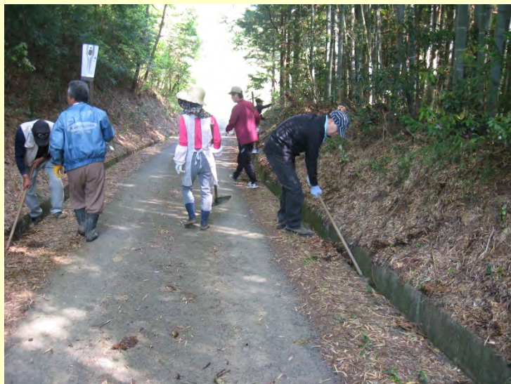
側溝の泥上げ
