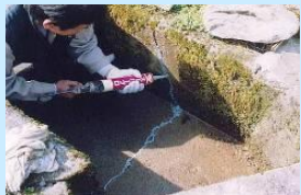
水路のひび割れ補修
