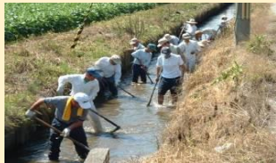
水路の泥上げ
