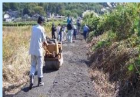
未舗装の農道を舗装
