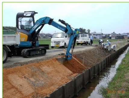
サポート隊による重機を使った法面整形
