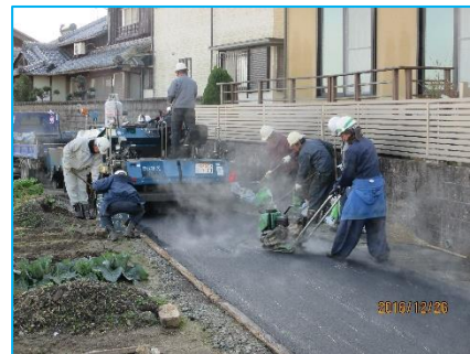
舗装工事は外注
