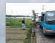
側溝・水路の土砂上げ
