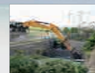
沈砂池の土砂上げ
