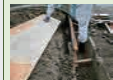
側溝浚渫・側溝補修を 多面的機能支払交付金にて実施
